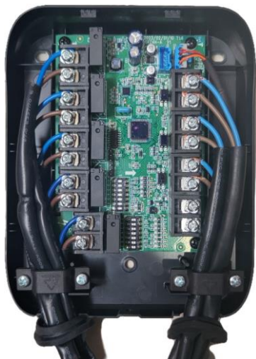
Рис. 5.3: Прокладання та кріплення кабелів.
